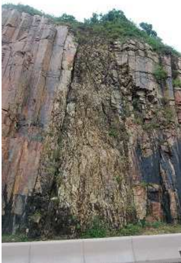
Fig. 5 断層による破砕帯
