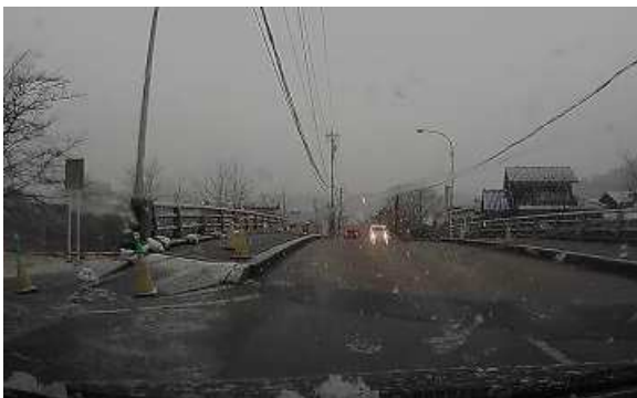
Fig. 4 穴水町 橋の段差
