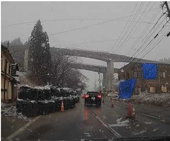
Fig. 3 穴水町 崖崩落箇所のおう
