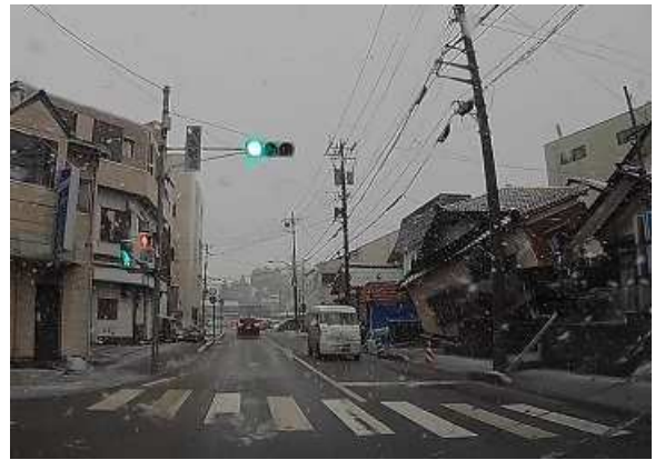
Fig. 5 穴水町 倒壊家屋
