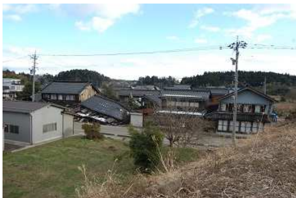
Fig. 6 能登町松波 ガード海側倒壊家屋
